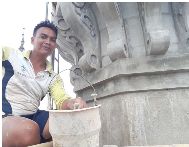
Gambar 26. Pekerjaan akhir finishing
