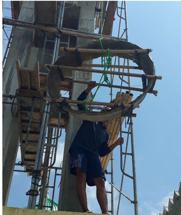
Gambar 17. Proses pengangkatan profil trumpet
