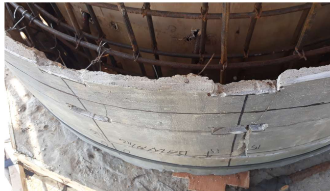
Gambar 18. Kunci profil beton trumpet di posisinya pada tulangan dinding
