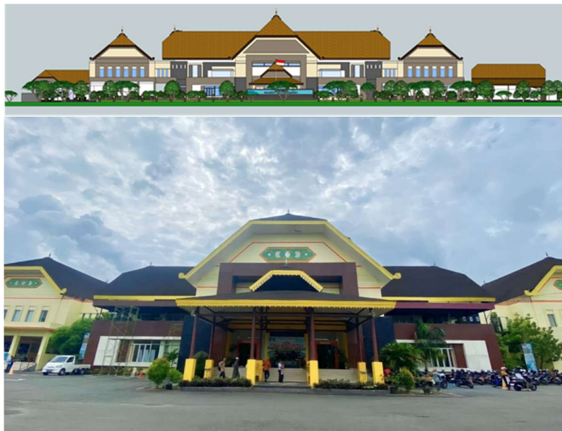
Gambar 1. Gedung Samsat 2 Banjarmasin
